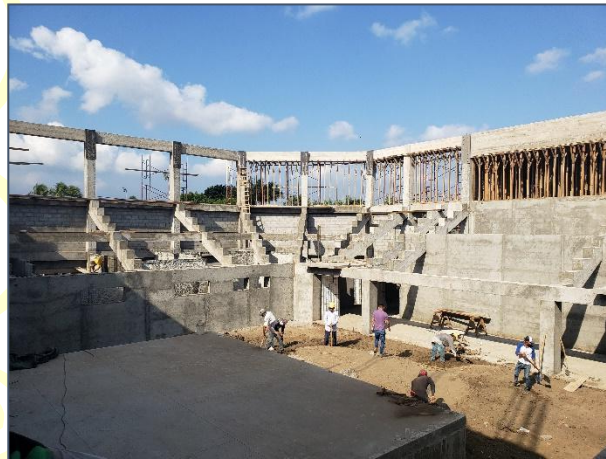
En ambas fotografías se muestra vista panorámica del Reemplazo de Gimnasio Multiusos (costado sur oeste a la izquierda). A la derecha observar vista panorámica del área de competencia. Apreciar la ejecución de las vigas raker que soportaran las graderías.
