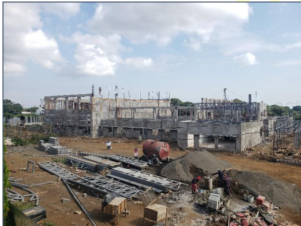
En ambas fotografías se muestra vista panorámica del Reemplazo de Gimnasio Multiusos (costado sur oeste a la izquierda). A la derecha observar vista panorámica del área de competencia. Apreciar la ejecución de las vigas raker que soportaran las graderías.
